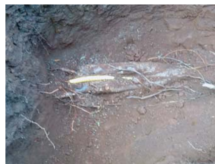
Et gasrør bliver kvalt af store rødder
