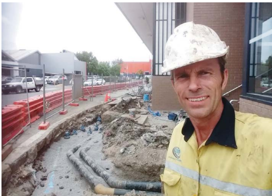
Her arbejder jeg i centrum af Brisbane. Rørarbejdet kræver kun at vandrør skal være minimum 300 mm nede i jorden. I Queensland er der aldrig problemer med frost, mens sommeren til gengæld kan være frygtelig varm.
