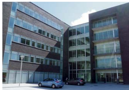
BJMF forventer at flytte ind i huset medio BJMF 2025.
