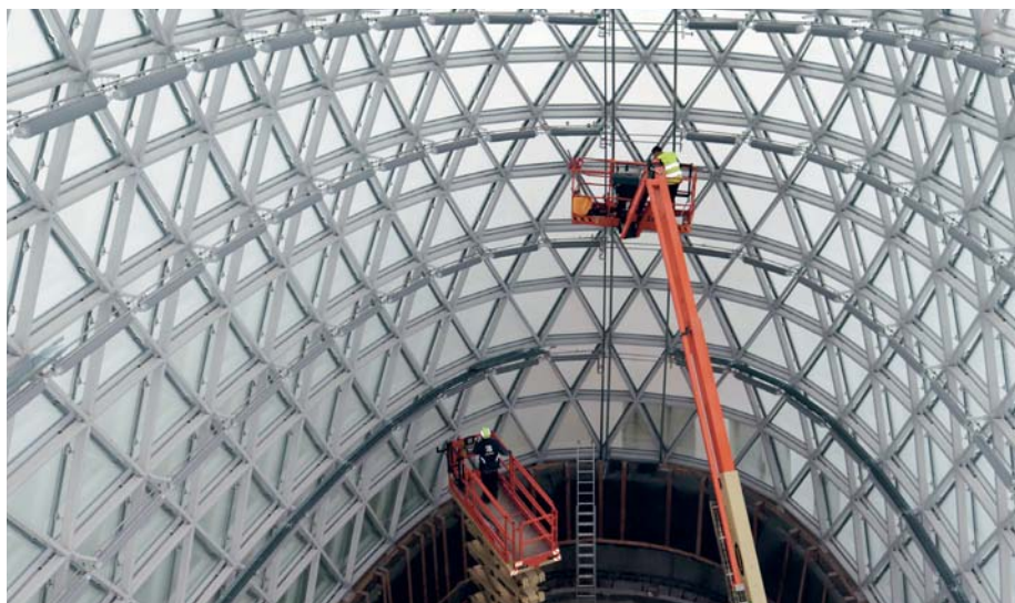
Wicotec Kirkebjerg har monteret 320 buede radiatorer i den ovale glassal.
